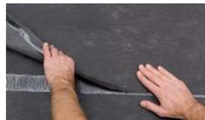
シート二枚目を接着面に重ねるように貼り付けます。
