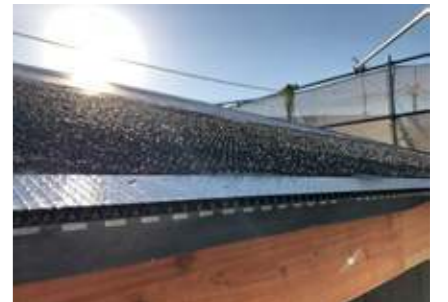
軒先、ケラバに通気口となるベントエッジを取り付けてください。
