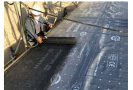
金属屋根とルーフィングシートの間施工してください。
