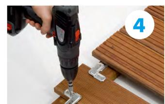
2枚目以降の床板は、1枚目と同じように裏側にコネクターをビス止めします。
