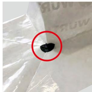
コーナー部分の防水補強処理により、漏水の原因となるピンホール発生を防止
