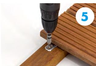
根太へ固定する際は、片方のコネクターが先に取付けた床板の下に隠れるように置いて位置決めをし、露出しているコネクターの丸穴にビスを打ちます。それ以降の床板も同様に固定します。
