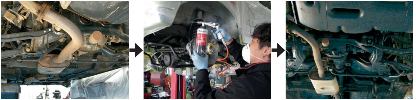
施工後の表面
