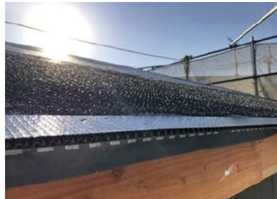
軒先、ケラバに通気口となるベントエッジを取り付けてください。
